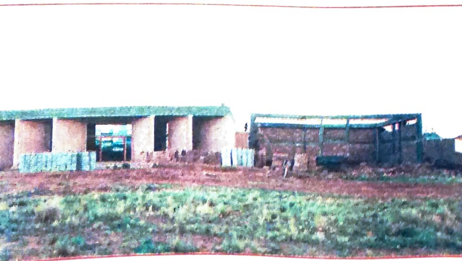
A la derecha, la Sala Bennett en construcción.
