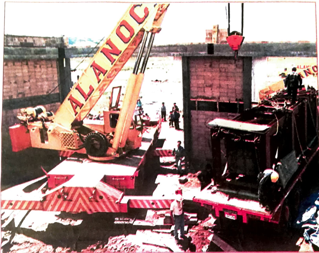
Momento en que el camión remolque ingresa a la sala en construcción.
