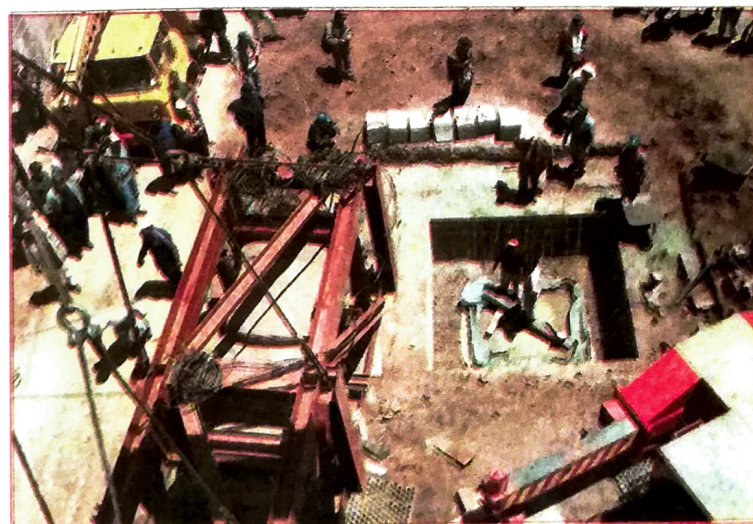
La fosa impermeabilizada de hormigón armado, recibiría al monolito.
